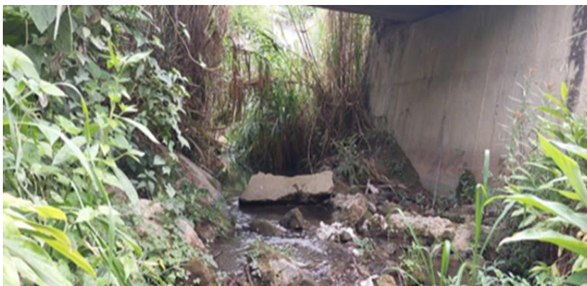
FIGURA N°02: TRAMO CRÍTICO EN LA QUEBRADA TOTALMENTE COLMATADA, SE REQUIERE REALIZAR LIMPIEZA Y DESCOLMATACION.
